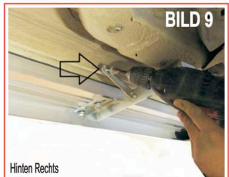
Der Befestigungspunkte für hinten rechts wird auf dem Bild 4 dargestellt.
