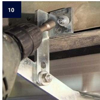
10 Verschrauben Sie die Zusatzhalter Screw on the additional holder
